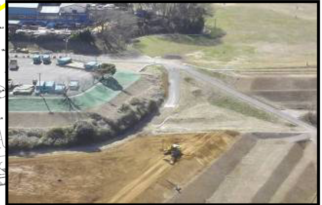
防草シート設置工事4800m 2
