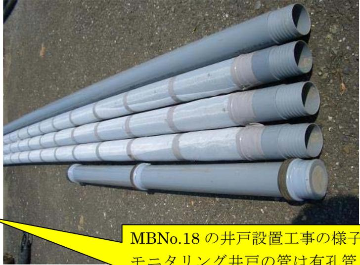
MBNo.18 の井戸設置工事の様子です。モニタリング井戸の管は有孔管（塩ビ製）で、先端は2mm 目のメッシュを2重に巻いています
