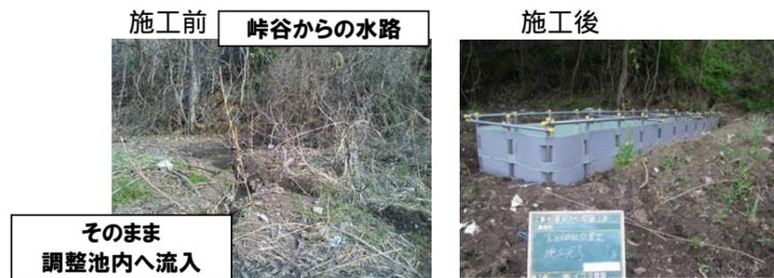
峠谷埋立区からの雨水集水路について、水路内に土砂が溜まっており、その上を水が流れている状況である。この部分について、土の撤去及び水路内の清掃を行った。また、土留め鋼板を設置して今後の土砂の流入を防止した。
