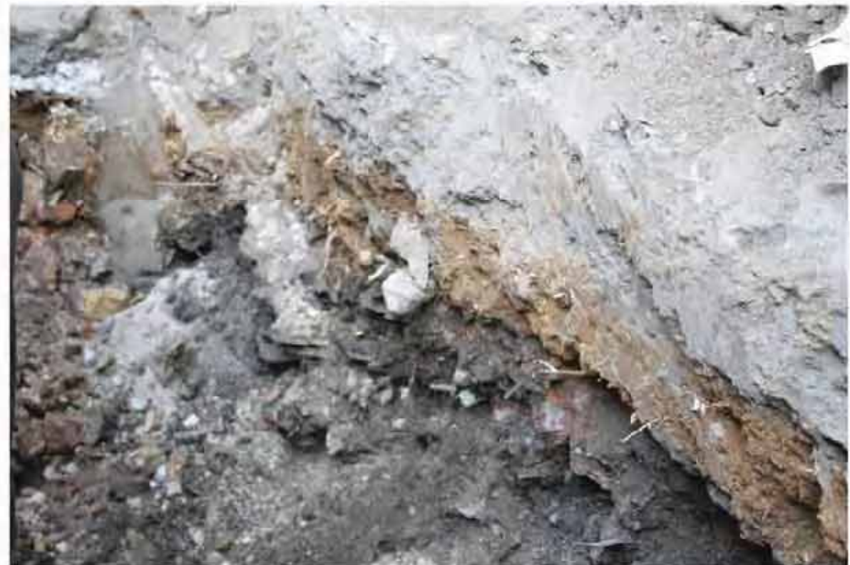
入孔箇所内部より壁面3
