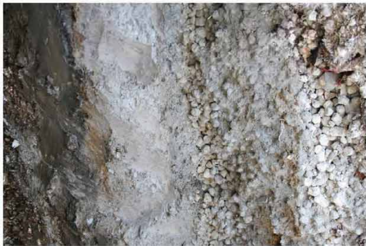
入孔箇所内部より壁面6
