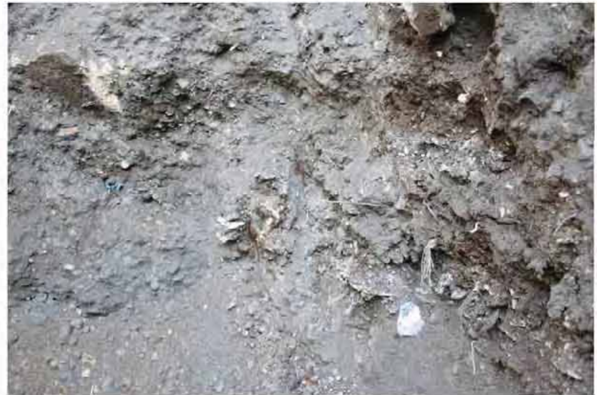
入孔箇所内部より壁面4
