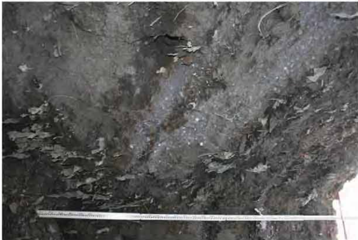
入孔箇所内部より壁面5
