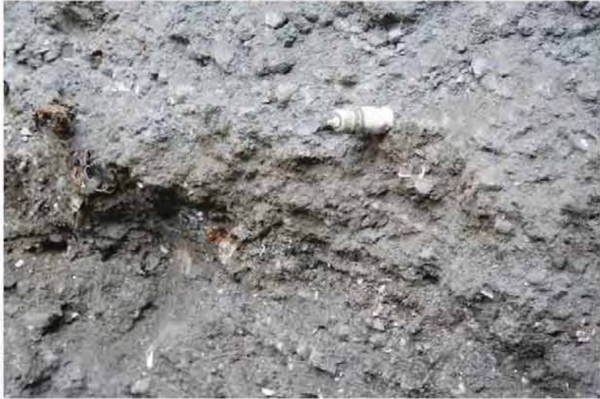
入孔箇所内部より壁面1
