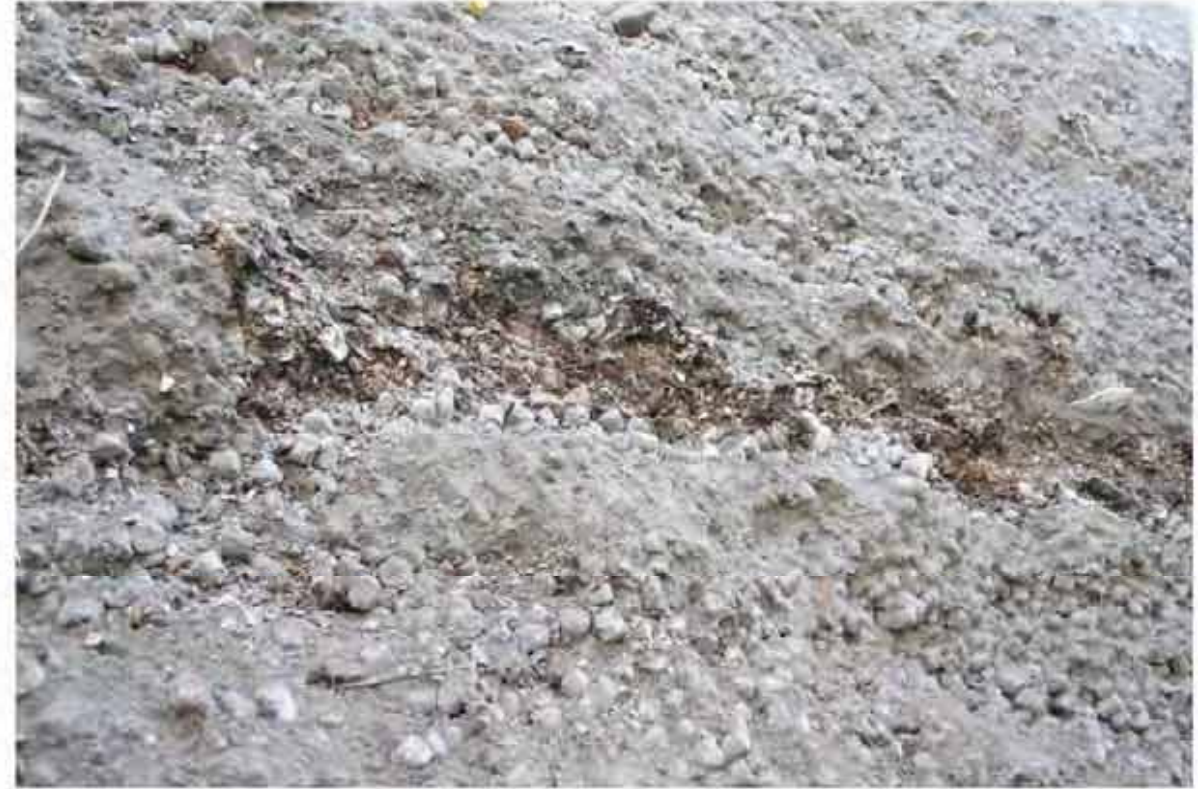
入孔箇所内部より壁面2
