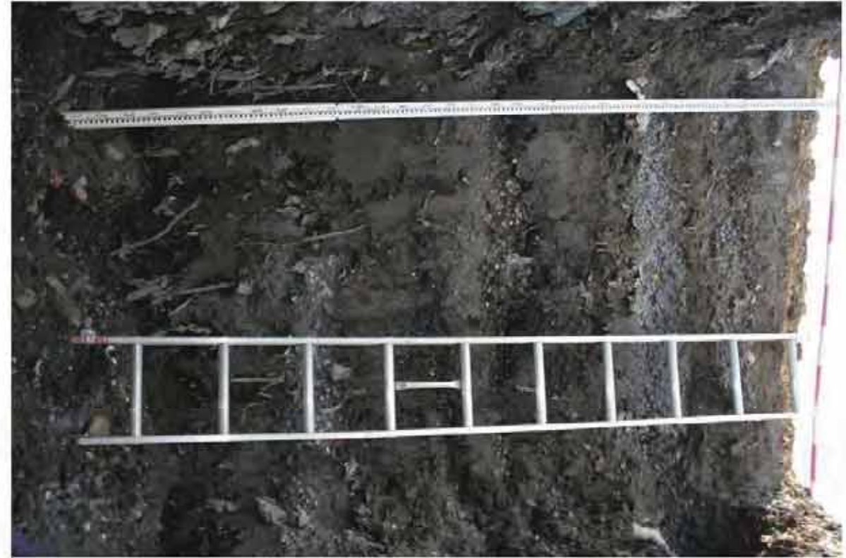
入孔箇所内部より壁面4
