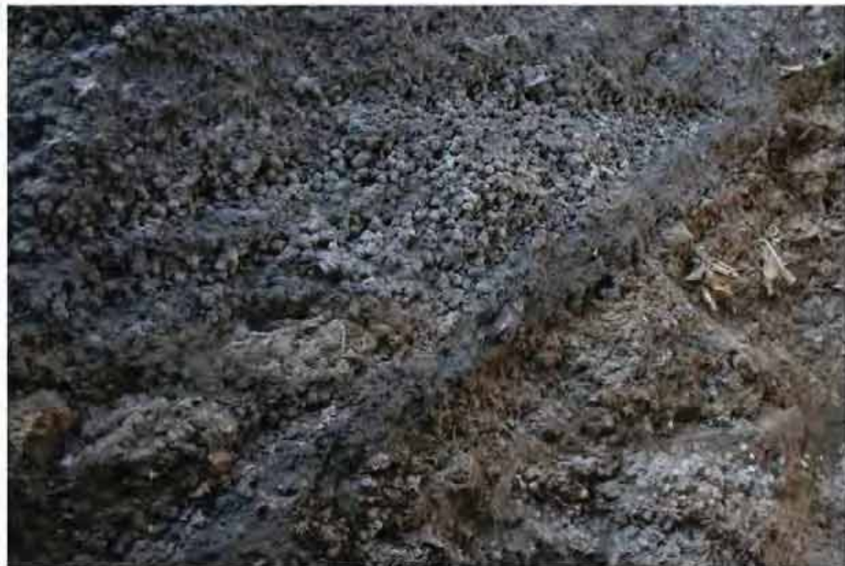
入孔箇所内部より壁面3
