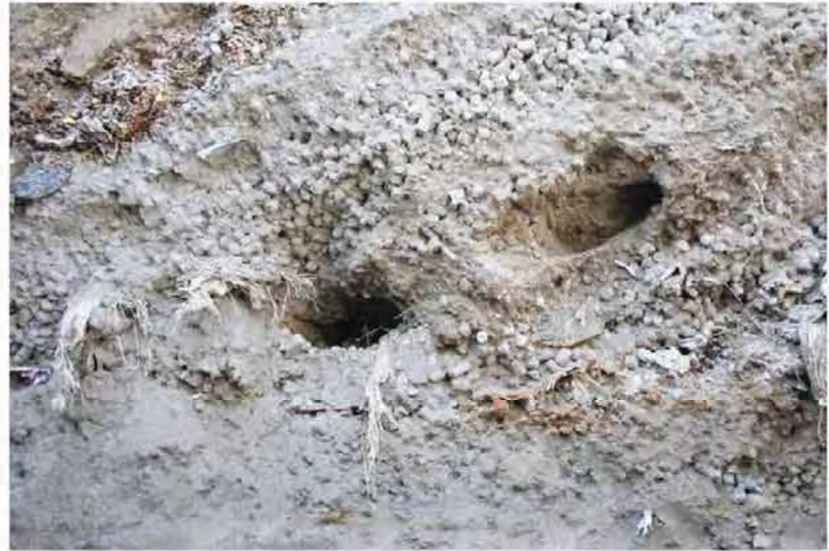
入孔箇所内部より壁面1
