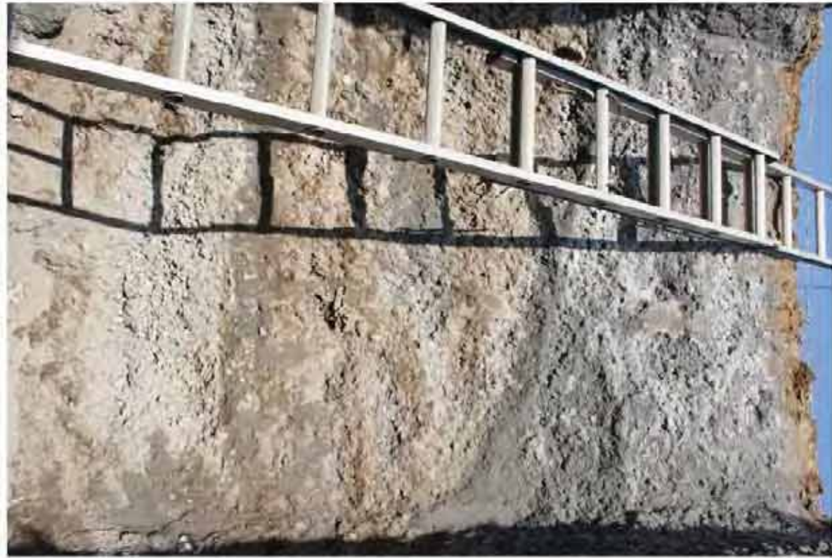
入孔箇所内部より壁面1
