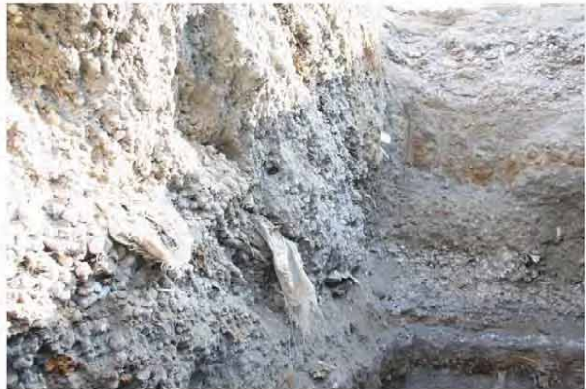
入孔箇所内部より壁面5
