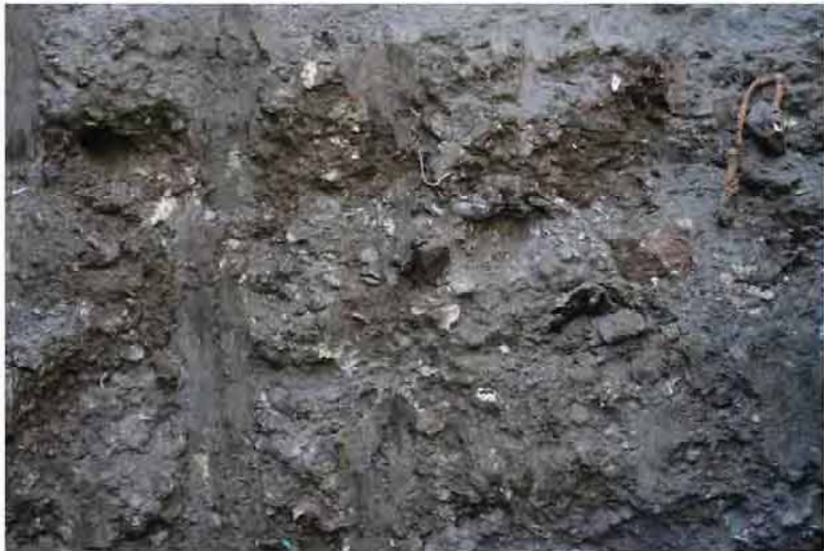
入孔箇所内部より壁面3
