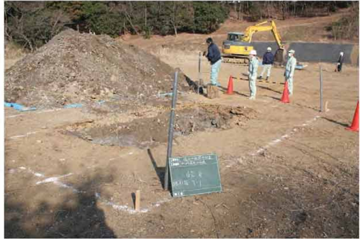
掘削作業完了
