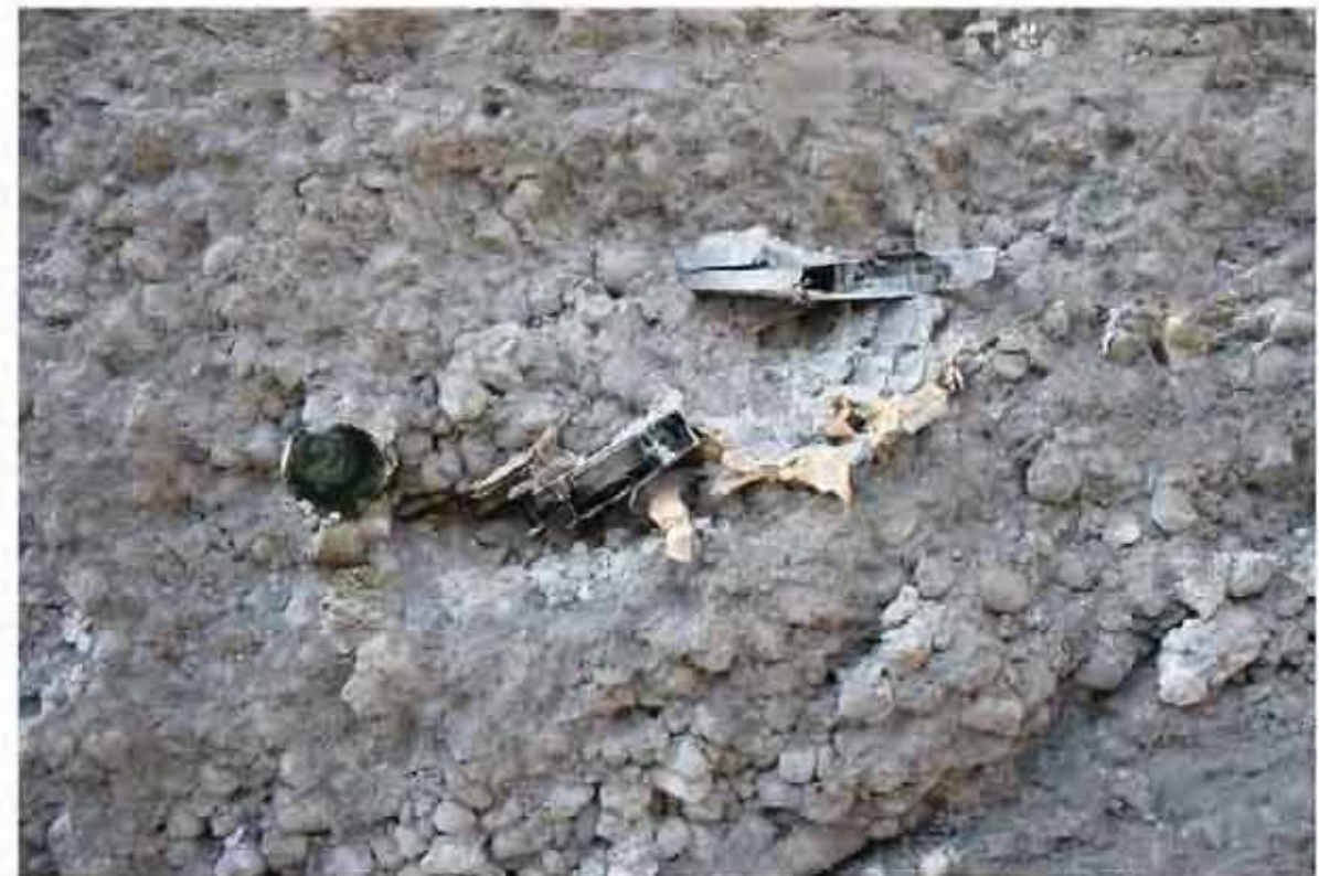
入孔箇所内部より壁面4
