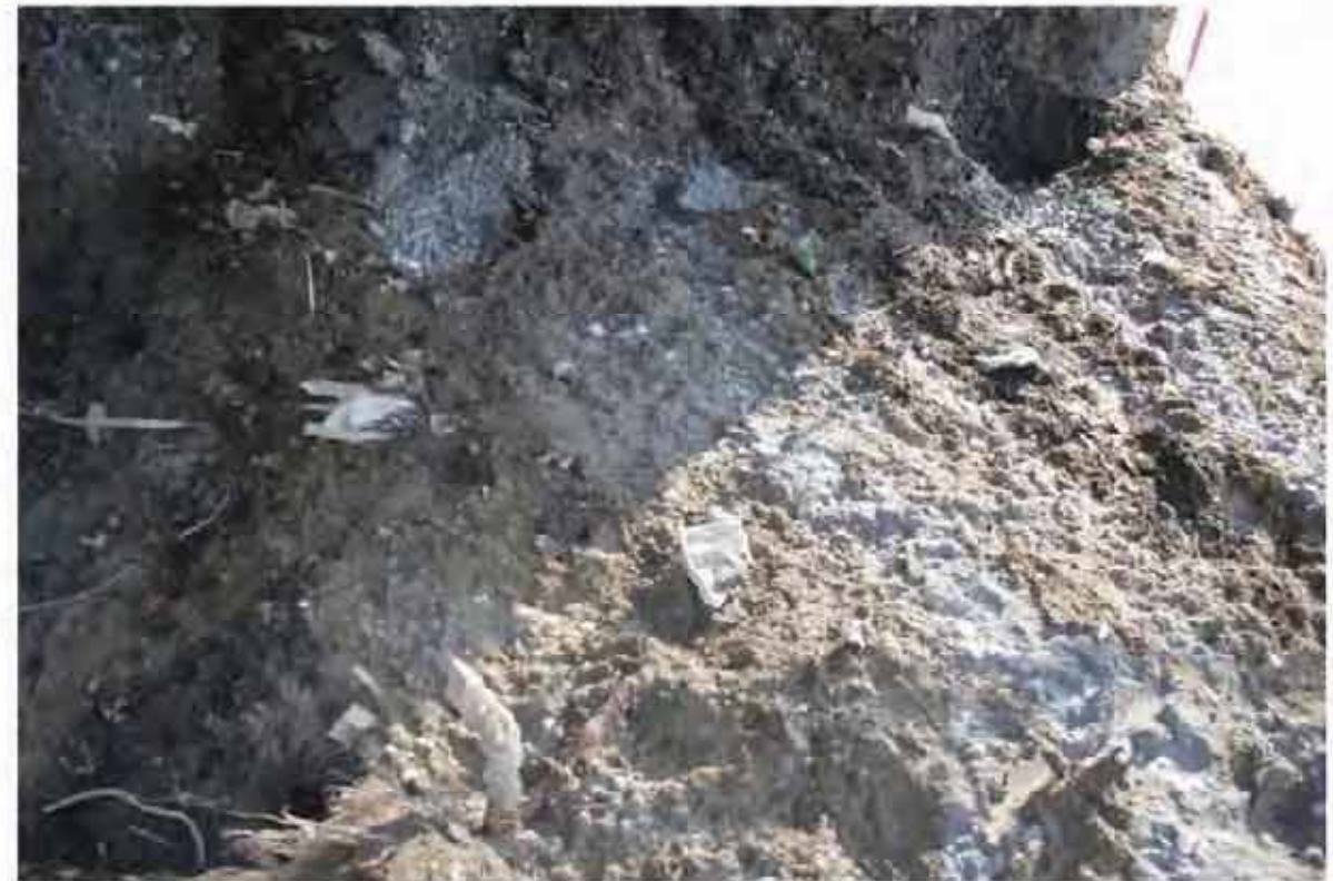
入孔箇所内部より壁面6
