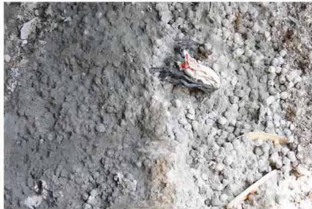
入孔箇所内部より壁面2
