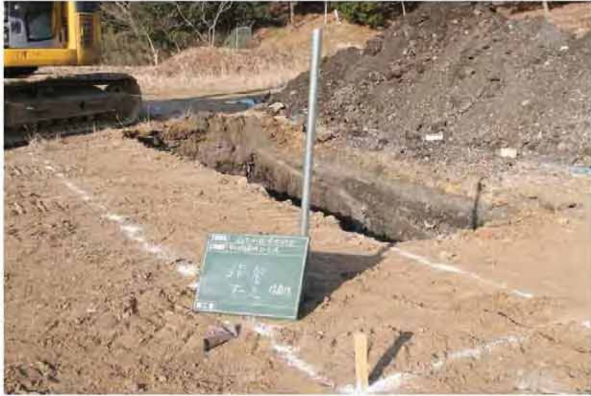
掘削作業完了
