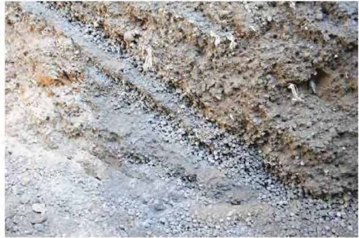
入孔箇所内部より壁面2
