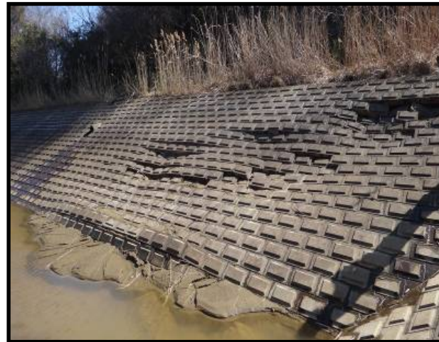
調整池補修工事予定箇所
