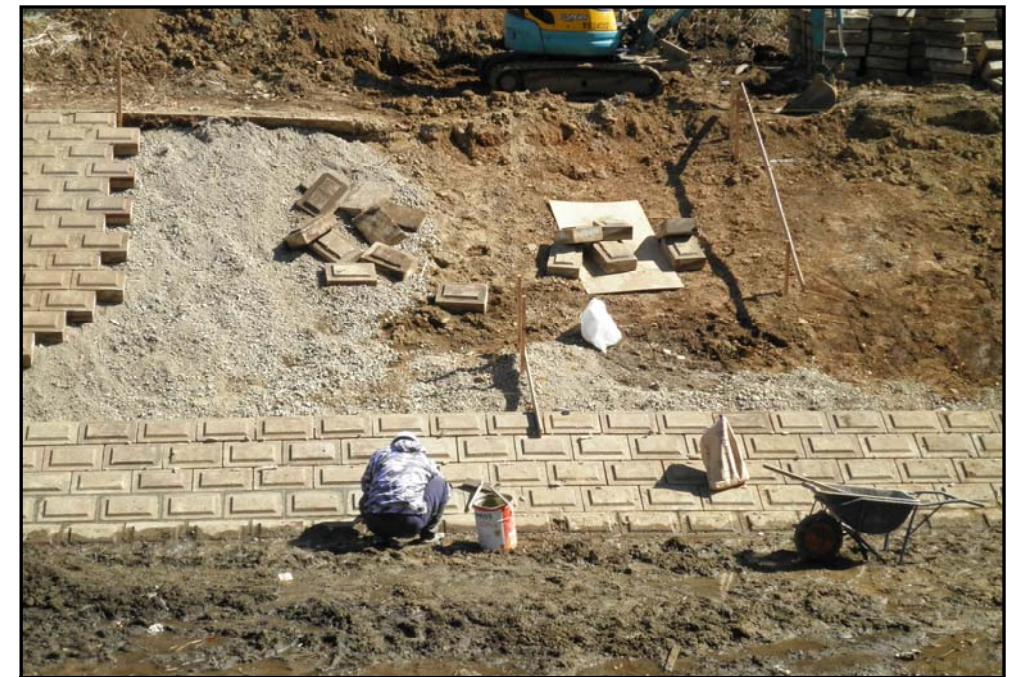
工事状況写真
