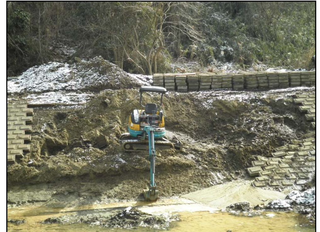
工事状況写真①
