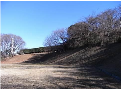
池の辺地区（緩衝斜面）
