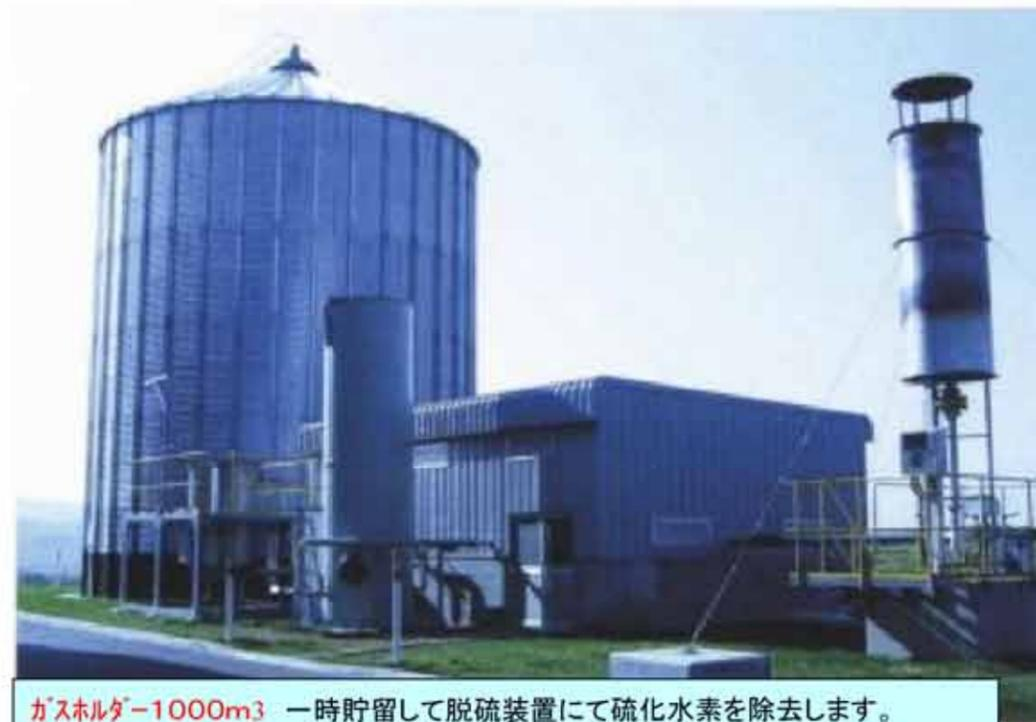
ガスホルダー-1000m<sup>3</sup> 一時貯留して脱硫装置にて硫化水素を除去します。
