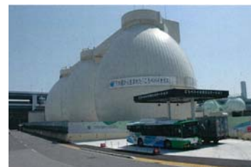
こうべバイオガスステーション
