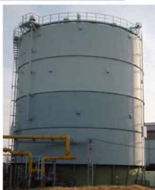
低圧貯留: φ 14.3m × 17.0mH (2,500m³)
