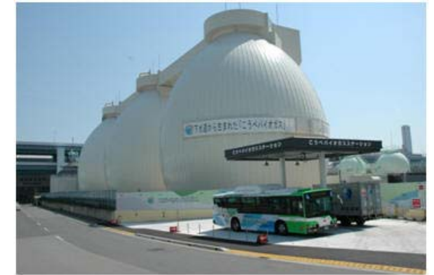
バイオガスステーション (神戸市)
