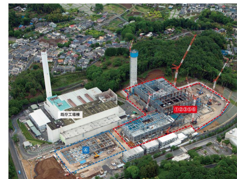
現場状況（2020年5月）
