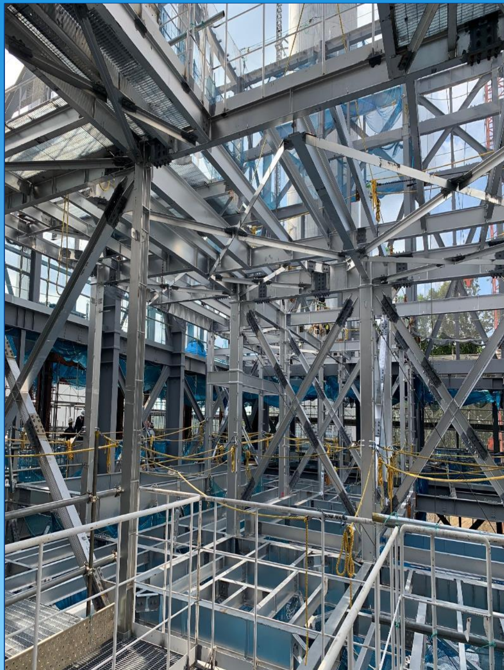
熱回収エリア 炉鉄骨施工状況 (6月23日)
