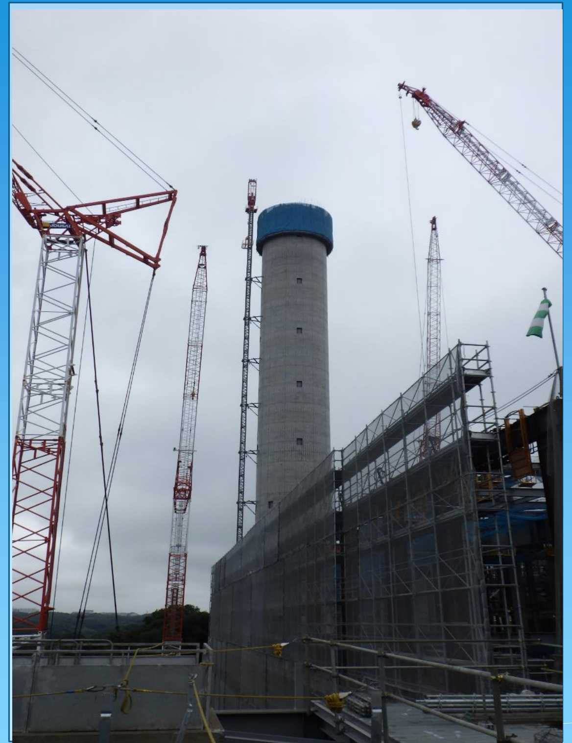
煙突 外筒施工状況 (6月30日)
