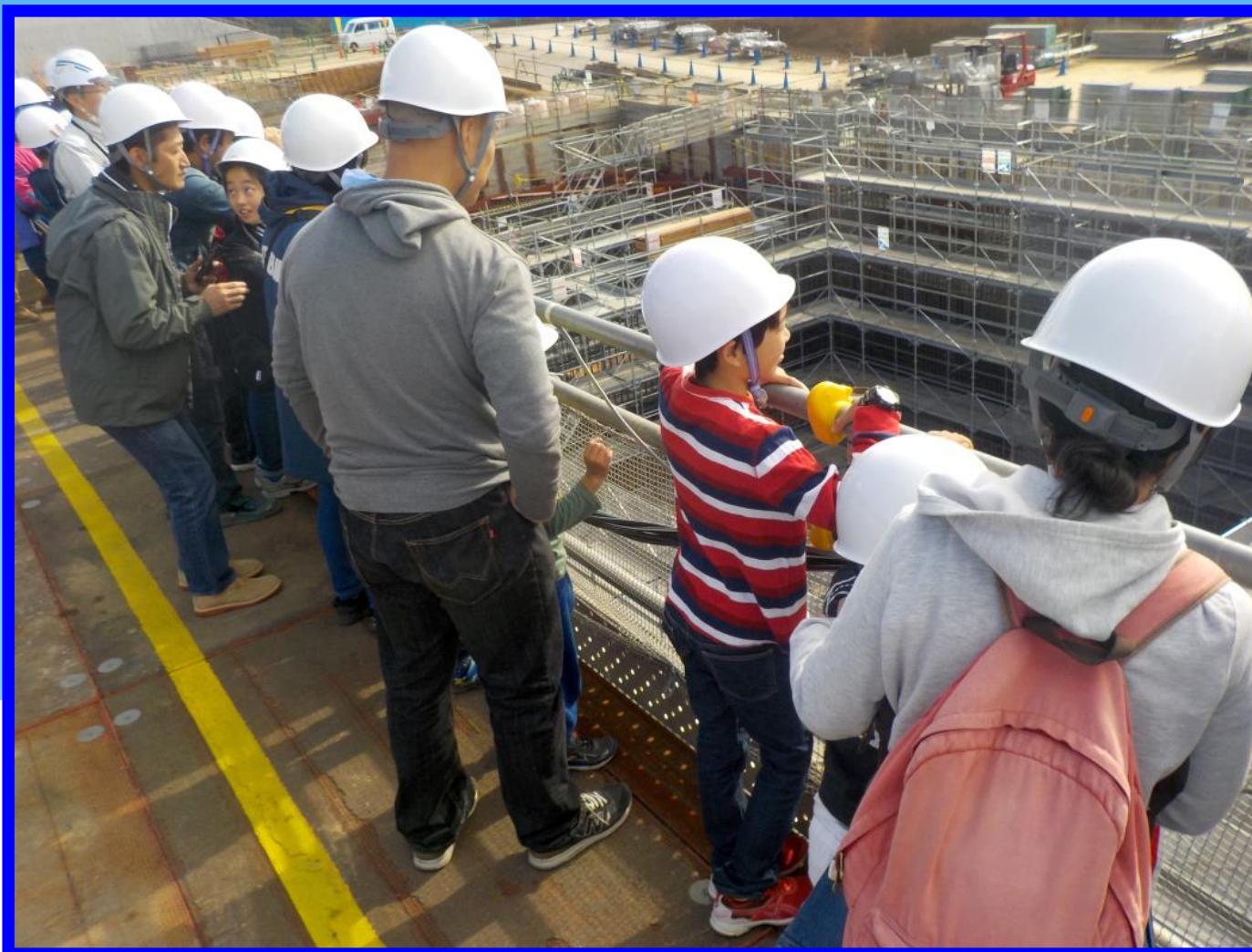
ごみピット見学
