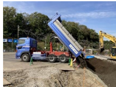
【ストックヤード棟建設に伴う土の搬入】
