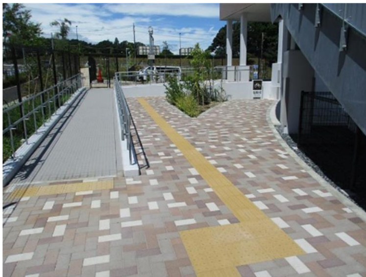
エコセメントが使用された通路（町田市バイオエネルギーセンター）
