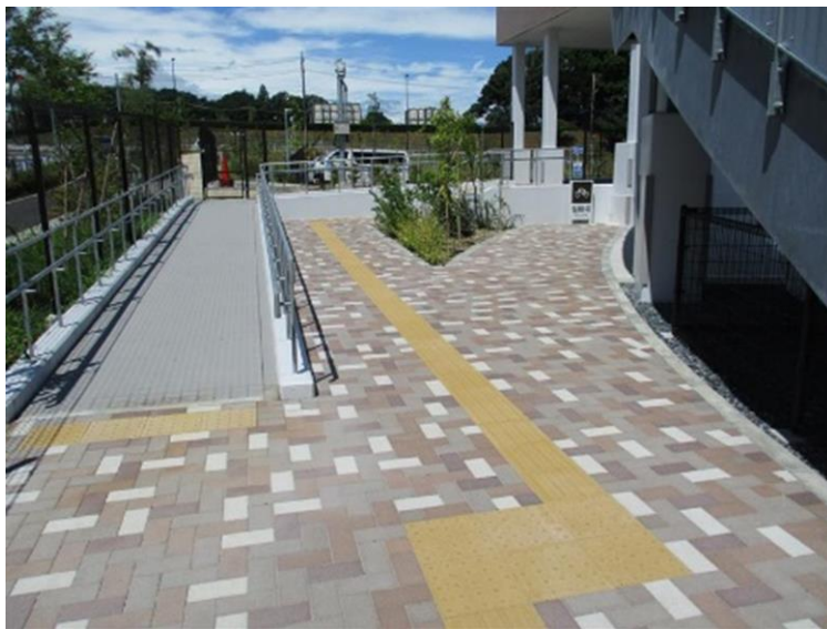
エコセメントが使用された通路（町田市バイオエネルギーセンター）
