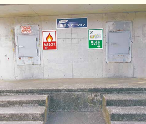
生徒が設置したごみ保管場所
