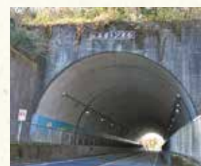
崖地を貫く真米トンネル
