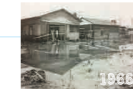
1966 台風4号による大雨で境川が氾濫した。改修前の境川は川幅が狭く、大きく蛇行していたため、大雨の度に深刻な被害が発生していた
