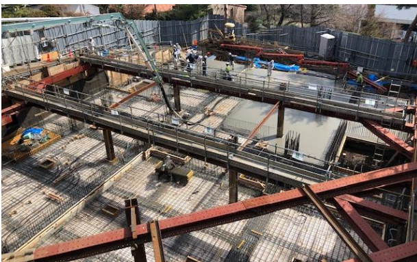
①躯体工事の様子 1
