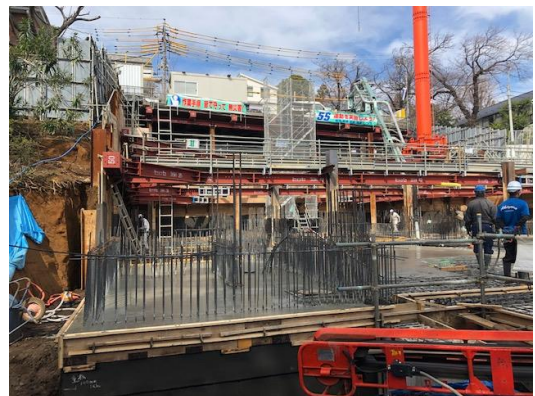
②躯体工事の様子 2
