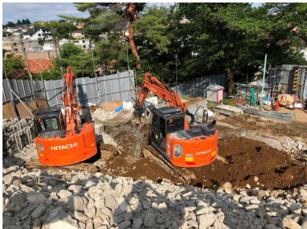
①解体工事の様子
