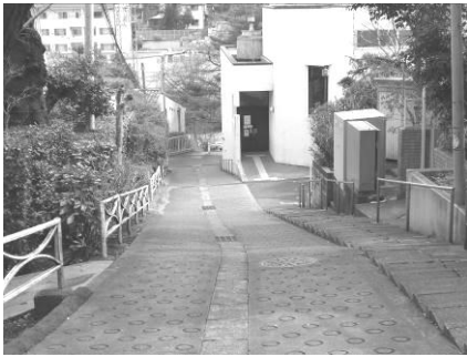
北側道路からコミュニティセンターの横を通り、階段道路に至る急傾斜の坂道
