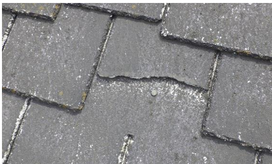
スレート屋根が劣化して割れている状態
