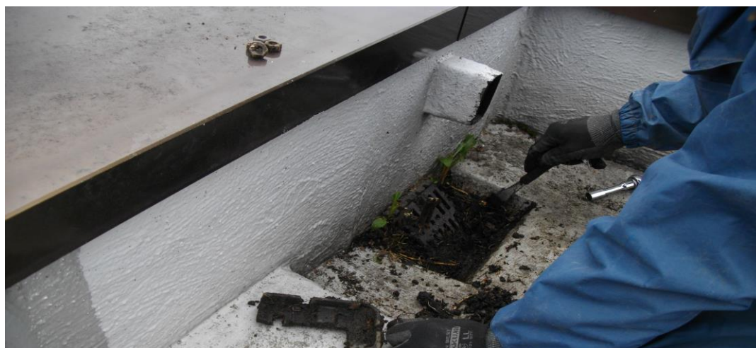
泥が溜まっている屋上のドレインの清掃事例
