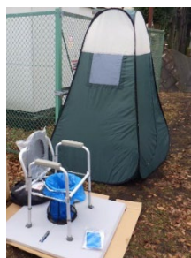
マンホールトイレ
