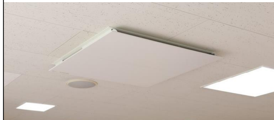
全熱交換機を設置
