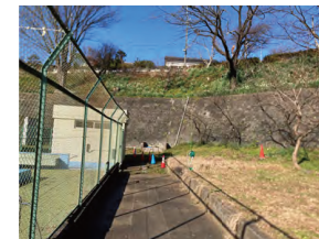
⑤北側擁壁・既存緑地
