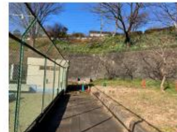
⑤北側擁壁・既存緑地
