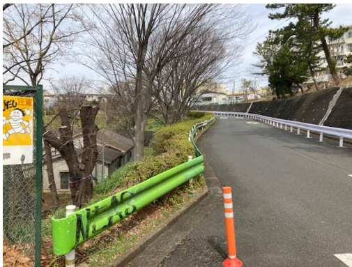
⑤ 5-1 北側歩道
