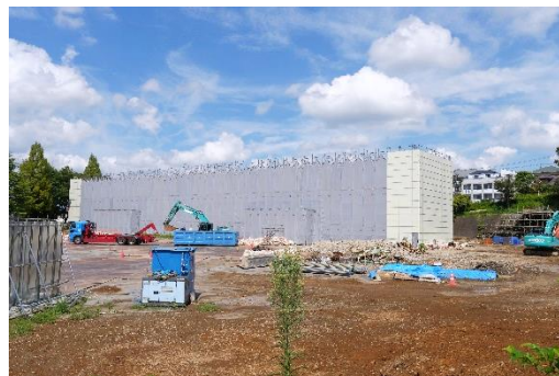
解体工事の状況（8 月）
