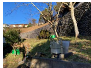
敷地北側の擁壁
