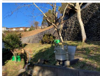
敷地北側の擁壁
