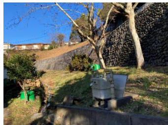
敷地北側の擁壁
