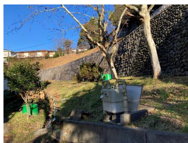
敷地北側の擁壁
