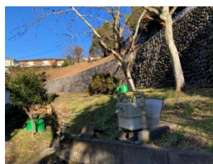
敷地北側の擁壁
