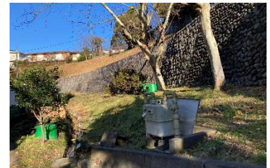
【敷地周囲の急な傾斜】
