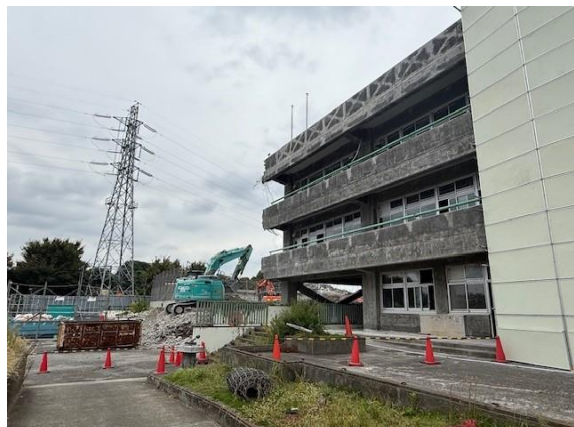
<解体工事の様子（2025年10月14日時点）>
