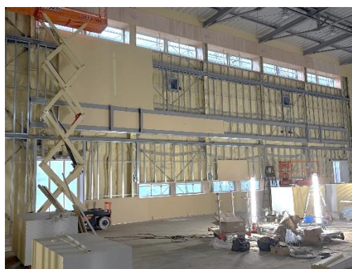
体育館棟の内観（内装工事中）
