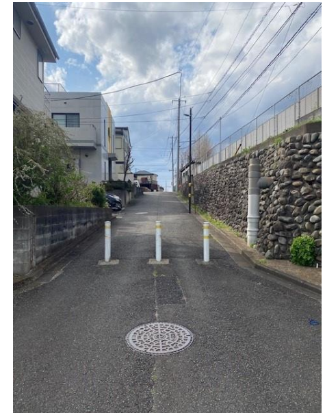
南西側道路及び玉石よう壁
