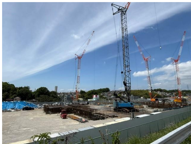
〈建設工事の様子（2026年5月7日時点）〉
