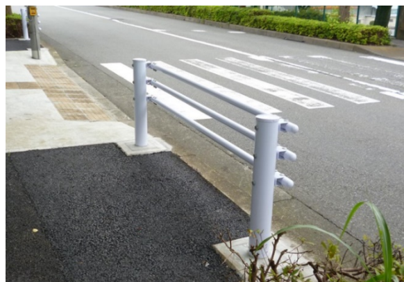
横断抑止柵設置
