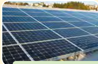
町田市立小・中学校の中では最大となる、30kWの太陽光発電パネル
