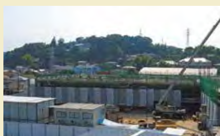
▲新しい校舎の建設が進んでいます
