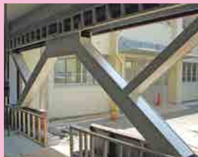
鉄骨を入れて建物の耐震性を高める
