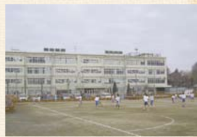
▲校舎の防音工事が完了
