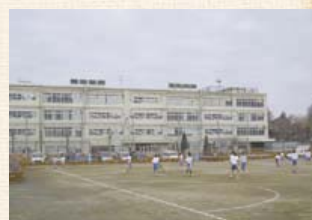
▲校舎の防音工事が完了
