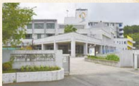
▲鶴川中学校 校舎外観
