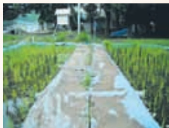
手作りの水田2面をつなぐ配水管
