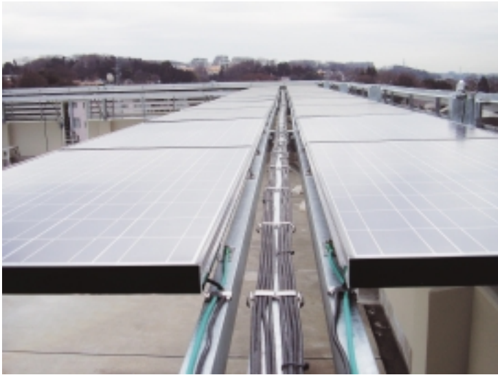
堺中プール日よけ部分に太陽光発電モジュールを設置
