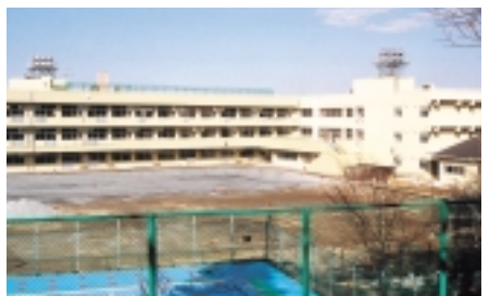
1年間の全面改修工事を終えた本町田小学校校舎
