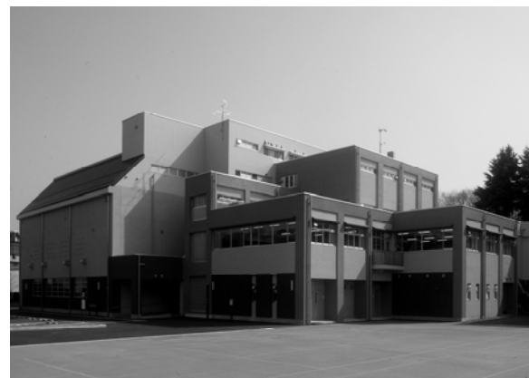
堺中学校体育館
