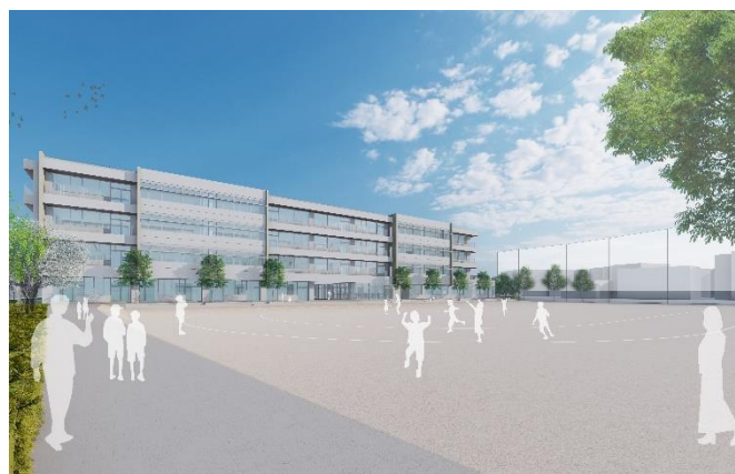
南側グラウンドから見た外観
