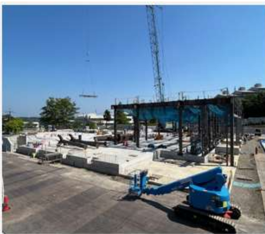
6月8日の建設地
