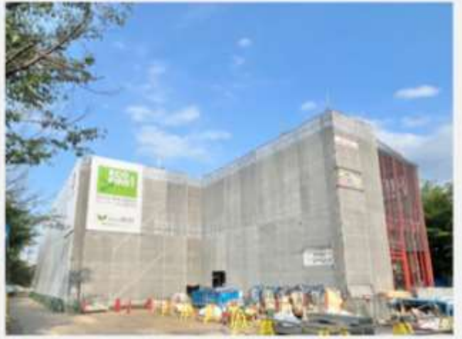
6月7日の建設地
