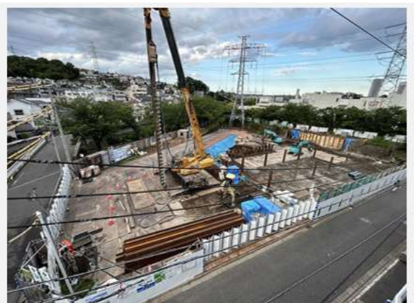
6月4日の建設地
